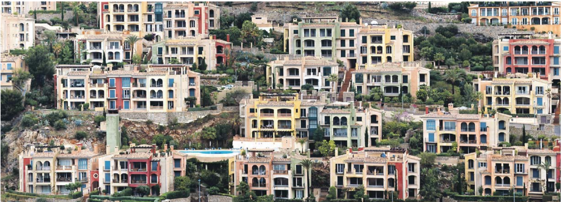
■ Die Abbildung gigantischer Eingriffe erfordert gigantische Formate: Eines der zehn Bilder, mit denen Gerd Neysters den mittlerweile abgeebbten Bauboom kommentiert.
